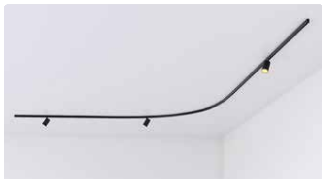
天井直付け施工（直線＋曲線）
